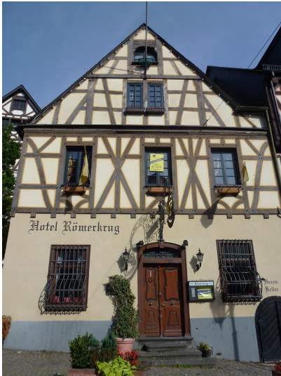
Fachwerkhaus am Marktplatz 1 in Oberwesel (2016) Fotograf/Urheber: Kira Bublies
