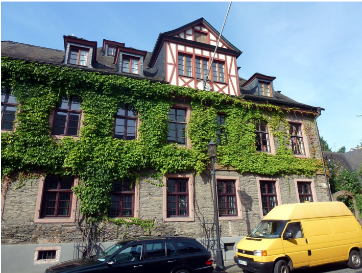
Wohnhaus in der Rathausstraße 1 in Oberwesel (2016): Das Haus im Zentrum der Stadt ist aufgrund der Forderung nach Material-sichtigkeit im 19. Jahrhundert unverputzt. Fotograf/Urheber: Anne Gasper
