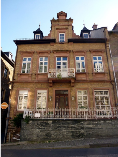
Schaarplatz 4 in Oberwesel (2016): Das zweigeschossige, traufständige Backsteinhaus, wurde 1887 errichtet. Fotograf/Urheber: Anne Gasper
