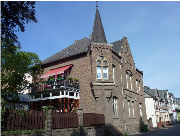
Die Winzervilla in der Liebfrauenstraße 17 in Oberwesel aus dem Jahr 1890 mit ihrer prunkvoll verzierten Fassade (2016). Fotograf/Urheber: Anne Gasper
