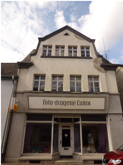
Wohnhaus in der Liebfrauenstraße 9 in Oberwesel (2016): Das Backsteinhaus stammt aus der Zeit um 1920-1930. Fotograf/Urheber: Anne Gasper
