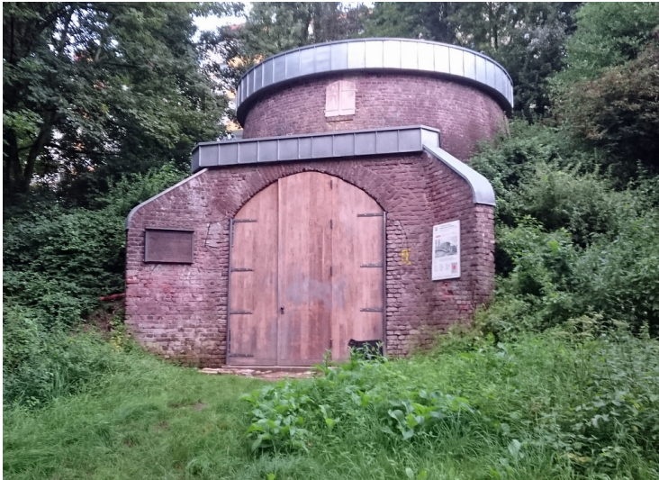
Der verbliebene Stumpf der früheren Turmwindmühle "Müllestumpe" in Bonn-Auerberg (2016) Fotograf/Urheber: Madeleine Weyand
