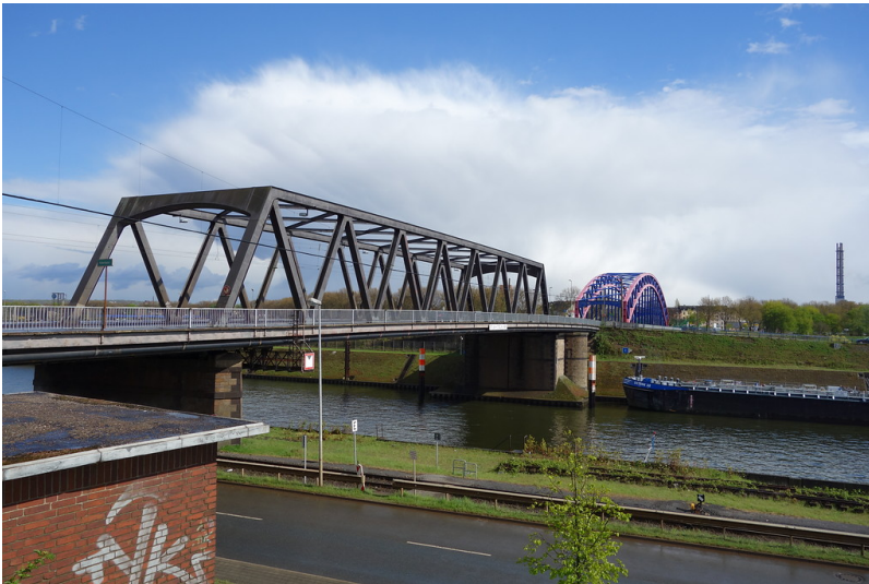
Karl-Lehr-Brückenzug in Duisburg-Ruhrort (2016) Fotograf/Urheber: Kai-William Boldt
