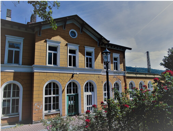
Bahnhofsgebäude in Oberwesel (2016) Fotograf/Urheber: Kira Bublies
