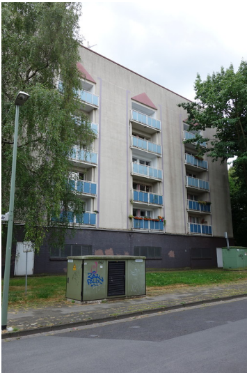
Hochbunker Nr 11 "Im Kirling" in Duisburg-Rheinhausen (2016) Fotograf/Urheber: Kai-William Boldt
