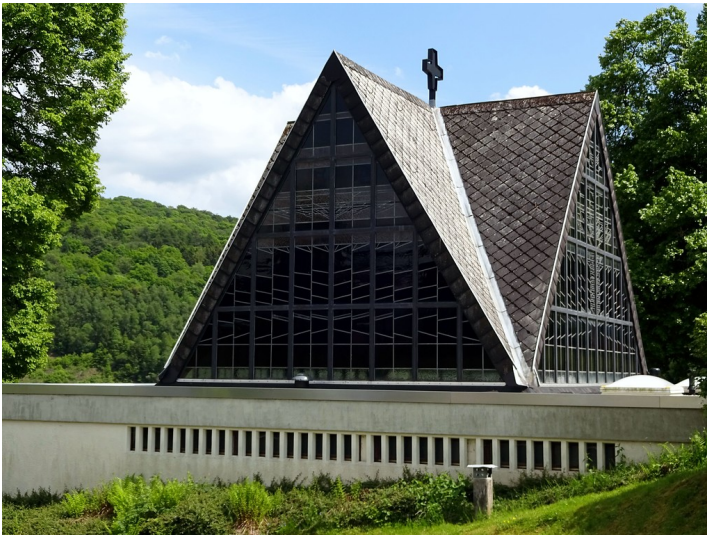
Kapelle auf dem Friedhof in Kastel (Nonnweiler) (2016) Fotograf/Urheber: Sabine Behrendt
