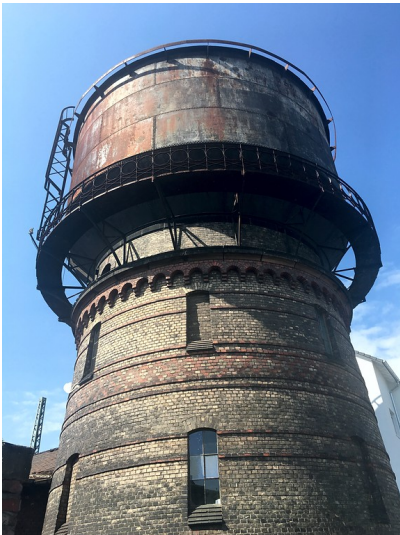
Wasserturm in Oberlahnstein (2016) Fotograf/Urheber: Milena Bagic
