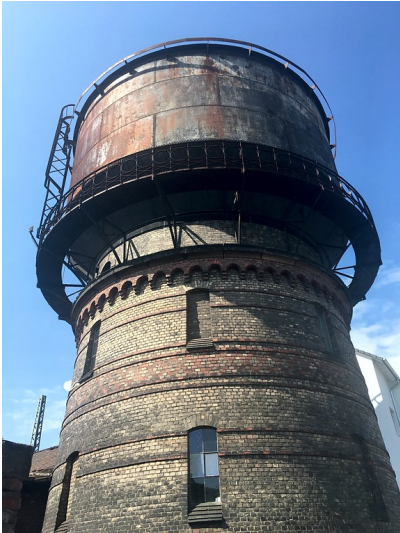
Wasserturm in Oberlahnstein (2016) Fotograf/Urheber: Milena Bagic
