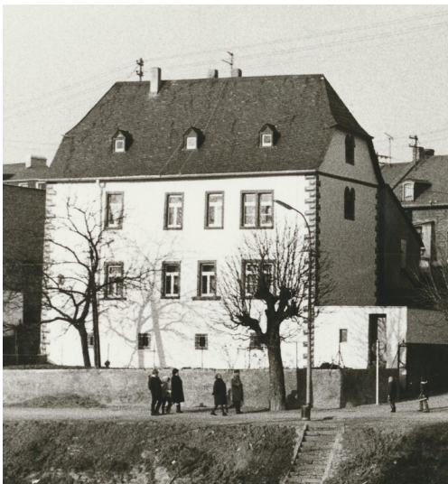
Heimbach'sches Haus vom Lahnufer aus gesehen Fotograf/Urheber: Stadt Lahnstein
