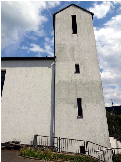
Turm der katholischen Pfarrkirche „Maria Himmelfahrt“ in Nonweiler-Braunhausen (2016). Fotograf/Urheber: Carina Köhler
