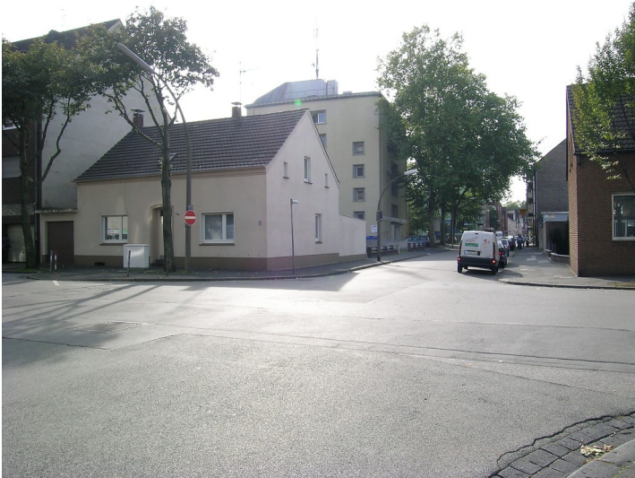
Hochbunker in der Günterstraße in Duisburg- Rheinhausen (2016) Fotograf/Urheber: Kai-William Boldt
