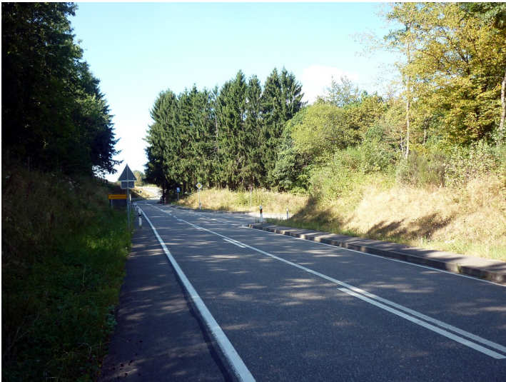
Die Dörrebach nach Argenthal verlaufende L 242 (2016) Fotograf/Urheber: Marius Scheffer
