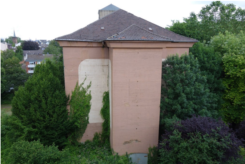
Hochbunker in Duisburg-Ruhrort (2016) Fotograf/Urheber: Kai-William Boldt
