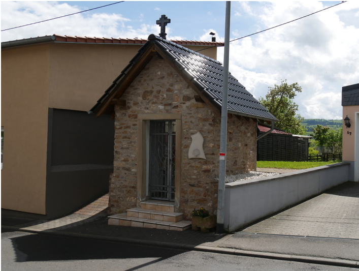
Frontansicht von Adlers Kapelle in Dörrebach (2017) Fotograf/Urheber: Jörn Schultheiß
