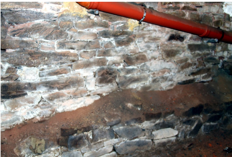
Kellergemäuer des AWO-Hauses in Nonnweiler mit alten Fundamenten (2016) Fotograf/Urheber: Naomi Straub
