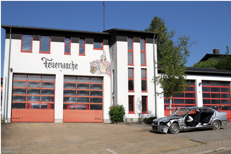
Feuerwehrhaus der freiwilligen Feuerwehr Nonweiler (2016) Fotograf/Urheber: Naomi Straub
