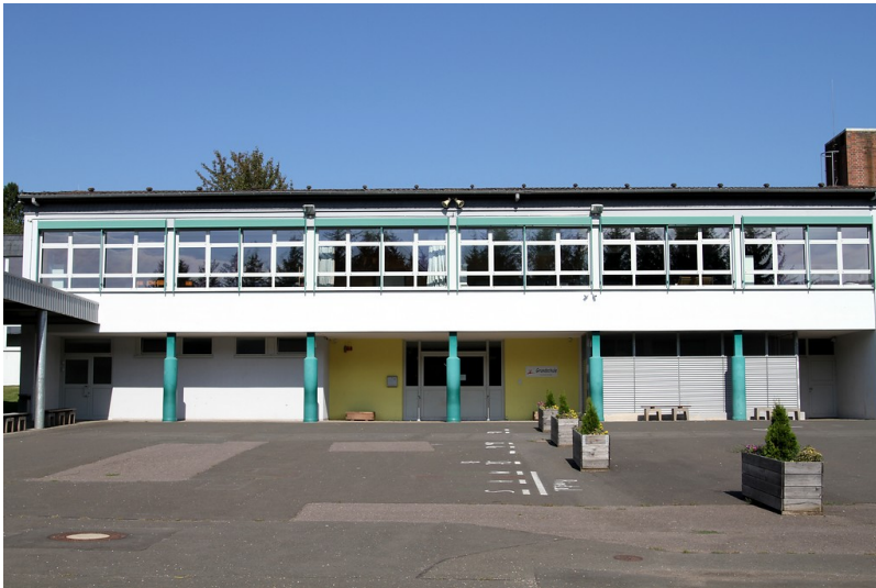
Hauptgebäude der Grundschule Nonweiler (2016) Fotograf/Urheber: Naomi Straub
