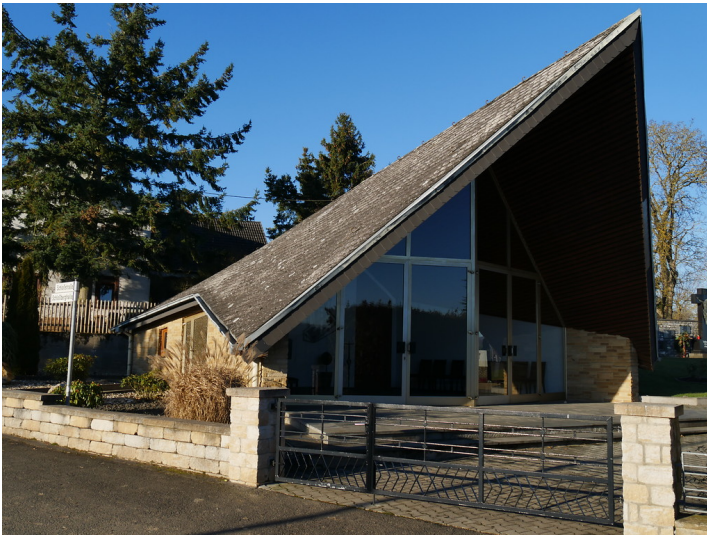
Seitenansicht des Andachtsgebäudes auf dem Friedhof in Dörrebach (2016) Fotograf/Urheber: Jörn Schultheiß
