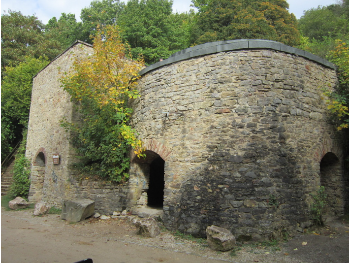
Nettersheim, Kalkbrennerei. Ansicht der beiden Kalkbrennöfen (2016) Fotograf/Urheber: Claus Weber
