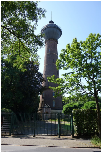
Wasserturm in Rheinhausen-Bergheim (2016) Fotograf/Urheber: Kai-William Boldt
