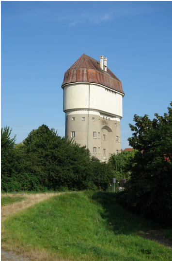
Doppelwasserturm Hohenbudberg (2016) Fotograf/Urheber: Kai-William Boldt
