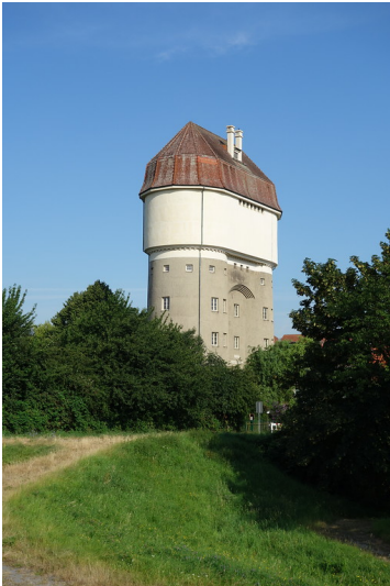
Doppelwasserturm Hohenbudberg (2016) Fotograf/Urheber: Kai-William Boldt
