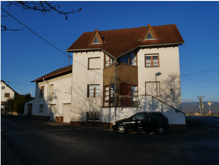
Frontansicht des Wohnhauses "Zitadelle" in der Soonwaldstraße 2 in Dörrebach, links der Anbau (2016). Fotograf/Urheber: Jörn Schultheiß
