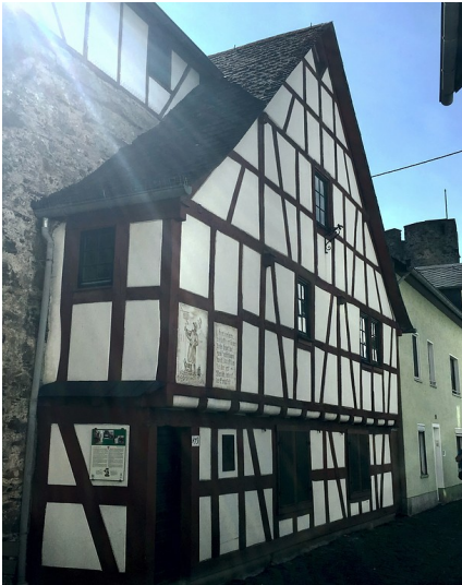
Stadtmauerhäuschen in Oberlahnstein (2016) Fotograf/Urheber: Milena Bagic
