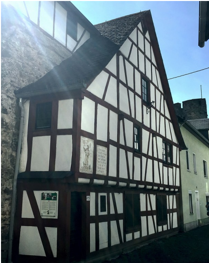
Stadtmauerhäuschen in Oberlahnstein (2016) Fotograf/Urheber: Milena Bagic
