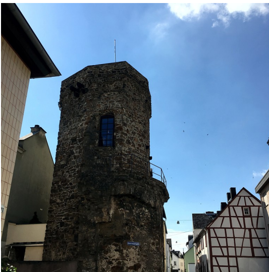
Bürgerturm in Oberlahnstein (2016) Fotograf/Urheber: Milena Bagic
