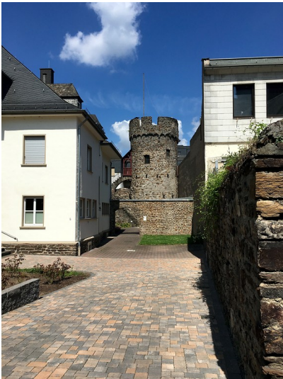
Salturm in Oberlahnstein (2016) Fotograf/Urheber: Milena Bagic
