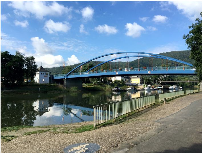
Die Rudi-Geil-Brücke in Lahnstein (2016) Fotograf/Urheber: Milena Bagic
