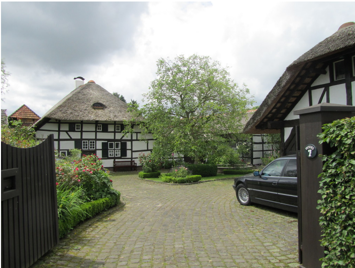
Fachwerkhofanlage mit Reetdach in Rickelrath (2016) Fotograf/Urheber: Nicole Schmitz
