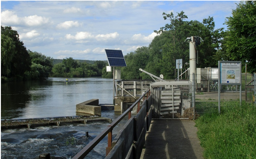
Das Siegwehr Buisdorf mit Fischpass und Kontrollstation für Wanderfische bei Sankt Augustin-Buisdorf (2016). Fotograf/Urheber: Franz-Josef Knöchel
