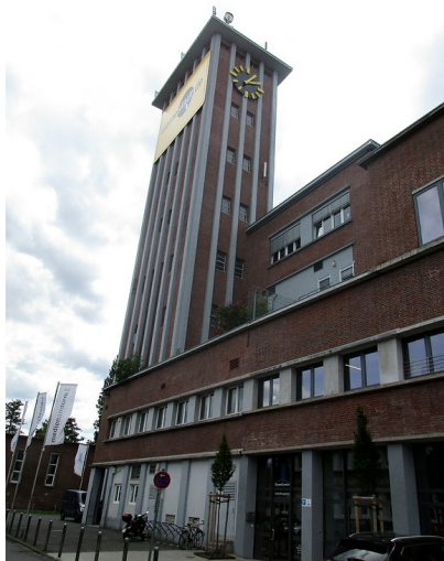
Der markante Turm im Süden des früheren Zentralgebäudes der ehemaligen Zellwolle-Werke "Phrix" der Rheinischen Zellwolle AG in Siegburg (2016). Fotograf/Urheber: Franz-Josef Knöchel
