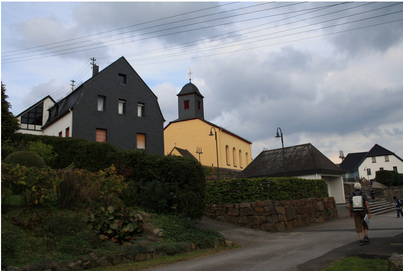
Pfarrkirche St. Chrysantius und St. Daria in Welcherath (2010) Fotograf/Urheber: Peter Burggraaff
