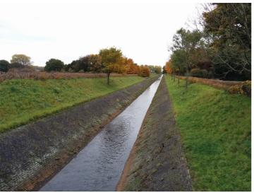
Der Kölner Randkanal entstand in der zweiten Hälfte der 1950er Jahre. Er fasst in einem gemauerten Kanal die Sümpfungswässer des Braunkohlentagebaus sowie Oberflächenabflüsse (2015). Fotograf/Urheber: Martina Gelhar
