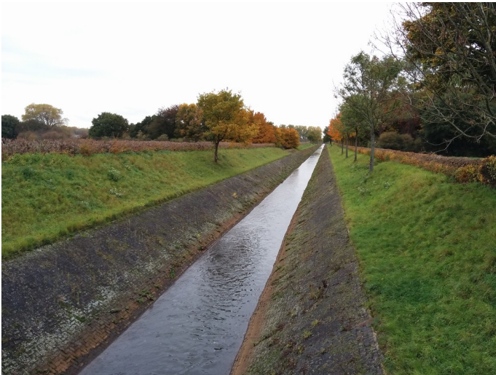
Der Kölner Randkanal entstand in der zweiten Hälfte der 1950er Jahre. Er fasst in einem gemauerten Kanal die Sumpfungswässer des Braunkohlentagebaus sowie Oberflächenabflüsse (2015). Fotograf/Urheber: Martina Gelhar
