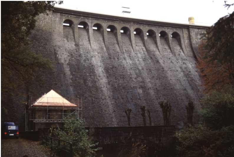
Die Sperrmauer der Aggertalsperre bei Engelskirchen, Oberbergischer Kreis (2007). Fotograf/Urheber: Wegener, Wolfgang
