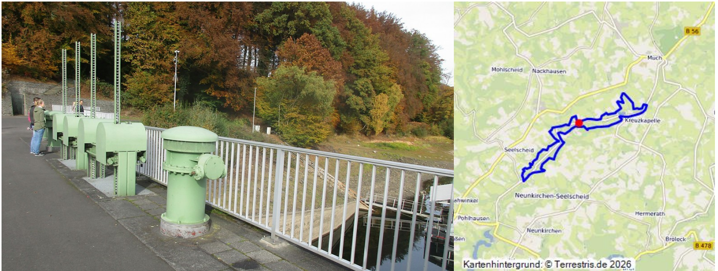
Staumauer der Wahnbachtalsperre mit Schützen zum Absperren oder Aufstauen des Wassers, Blick in westliche Richtung (2016).
