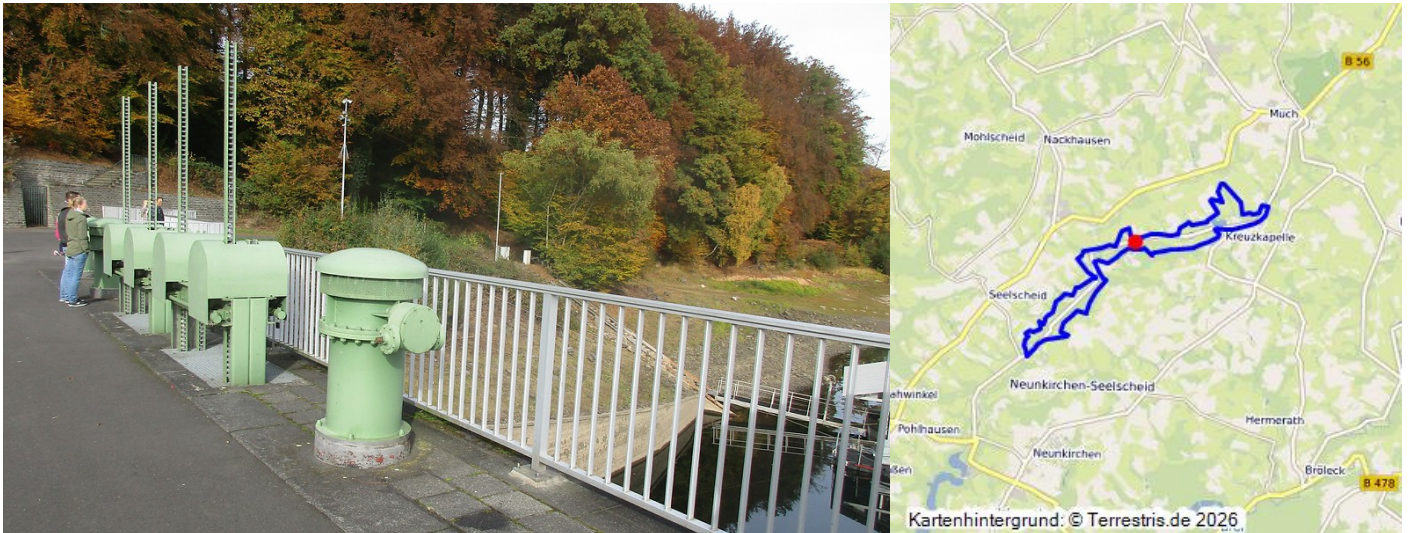
Staumauer der Wahnbachtalsperre mit Schützen zum Absperren oder Aufstauen des Wassers, Blick in westliche Richtung (2016).
