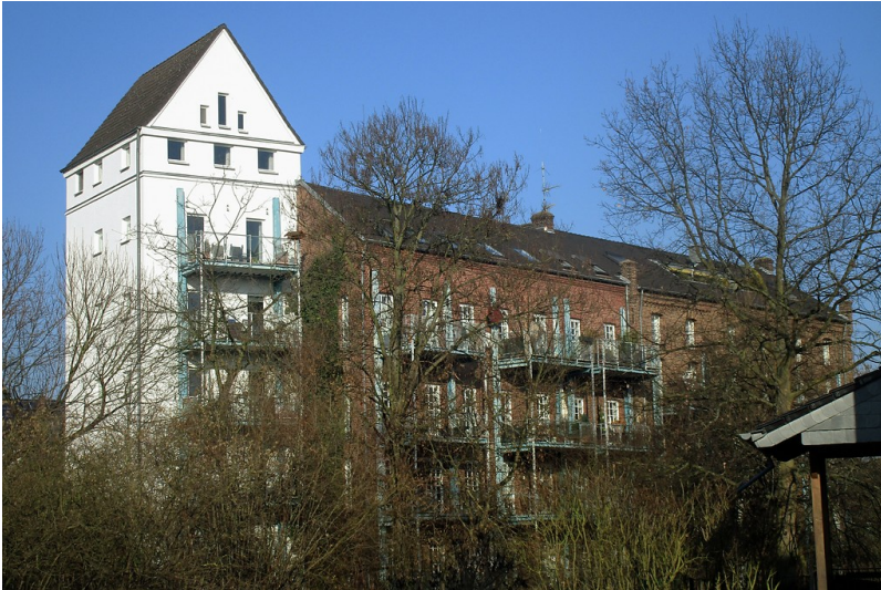
Sieglarer Mühle in Troisdorf-Sieglar, rückwärtige Ansicht vom Mühlengraben aus (2017). Fotograf/Urheber: Franz-Josef Knöchel
