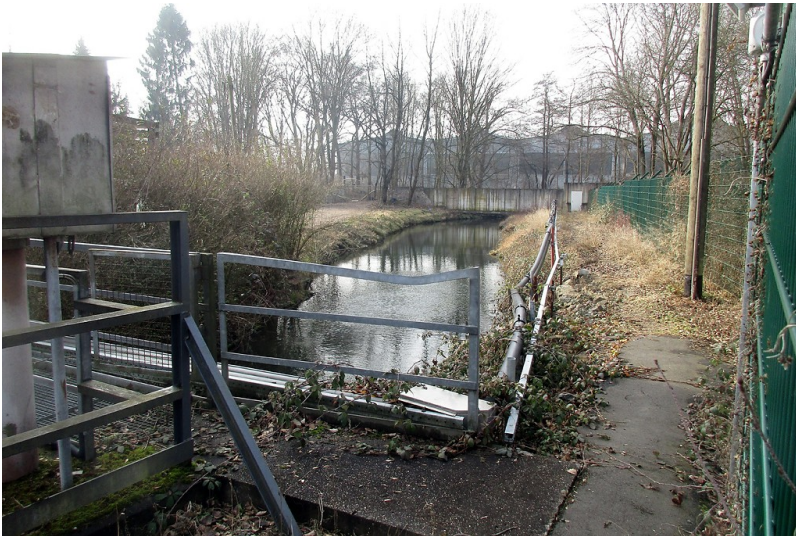
Stau- und Wehranlagen am Abzweig des Troisdorfer Mühlengrabs von der Agger, im Hintergrund Teile des früheren Hüttenwerks Friedrich-Wilhelms-Hütte, heutige Mannstaedt-Corus GmbH (2017). Fotograf/Urheber: Franz-Josef Knöchel
