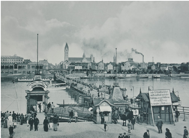
Ansicht von Deutz von der Stadtköln Seite (1896). Im Bildvordergrund der Zugang zur Pontonbrücke, auf der anderen Rheinseite links die Badeanstalt und der "Mindener Bahnhof" der Köln-Mindener Eisenbahn, rechts der Brücke Lastkähne, Sankt Heribert und die St. Johanneskirche. Mittig vor der 1892-1896 erbauten Pfarrkirche St. Heribert ist die damalige zweite Deutzer Synagoge (1786-1914) auszumachen.
