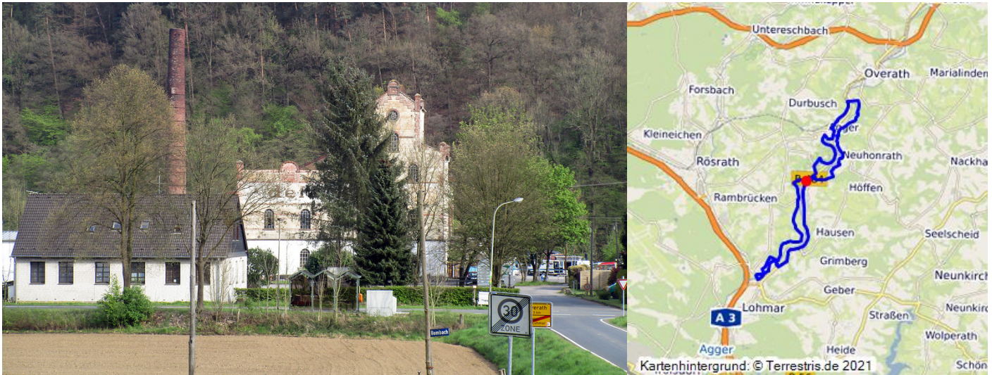
Blick von Bombach bei Lohmar-Honrath auf den Wohnplatz Aggerhütte mit dem Gewerbegebiet Aggerhütte / Aggermühle (2017). Fotograf/Urheber: Franz-Josef Knöchel
