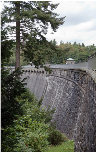
Wipperfürth-Großblumberg, Neyetalsperre, Staumauer (2014) Fotograf/Urheber: Silvia Margrit Wolf
