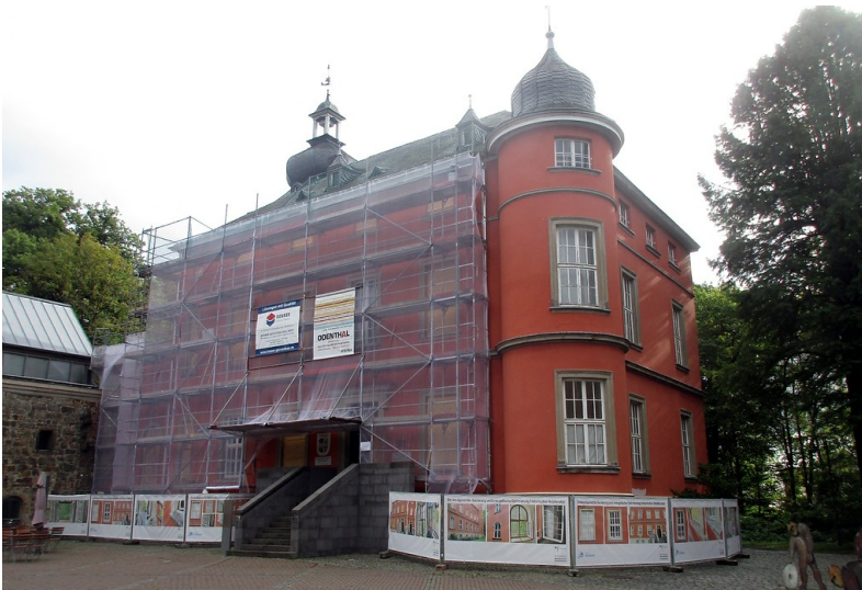
Ansicht des in Renovierung befindlichen Hauptgebäudes von Burg Wissem in Troisdorf (2016).
