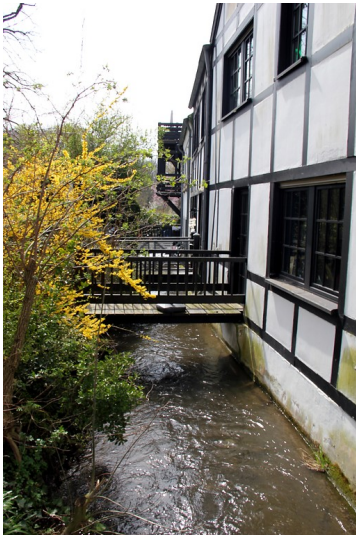
Strunde mit der Wichheimer Mühle in Köln-Holweide (2015). Fotograf/Urheber: Peter Burggraaf
