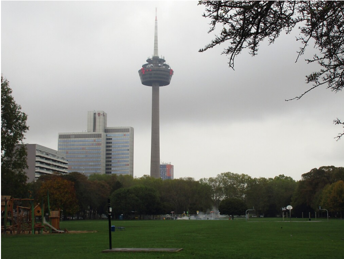
Der Fernmeldeturm "Colonius" in Neustadt-Nord, Ansicht vom Inneren Grüngürtel im Bereich der Venloer Straße (2020). Fotograf/Urheber: Franz-Josef Knöchel
