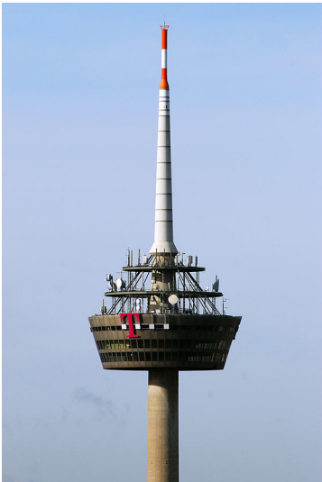
Der obere Bereich des Kölner Fernmeldeturms "Coloniuss" mit der dreigeschossigen Turmkanzel und den Sendeanlagen (2008). Fotograf/Urheber: Emilio Garcia
