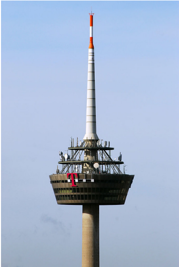
Der obere Bereich des Kölner Fernmeldeturms "Coloniuss" mit der dreigeschossigen Turmkanzel und den Sendeanlagen (2008). Fotograf/Urheber: Emilio Garcia
