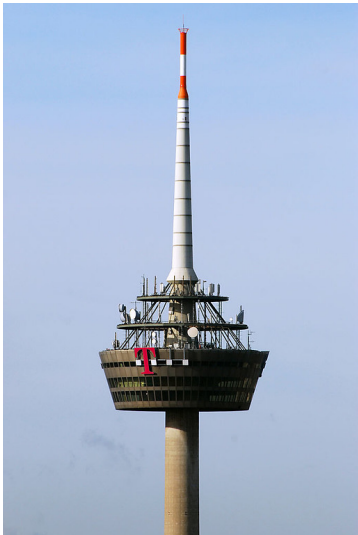
Der obere Bereich des Kölner Fernmeldeturms "Coloniuss" mit der dreigeschossigen Turmkanzel und den Sendeantennen (2008). Fotograf/Urheber: Emilio Garcia
