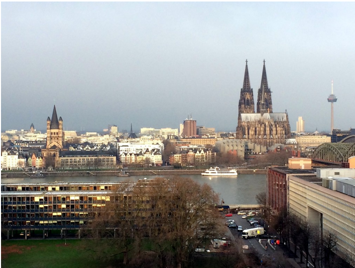
Blick auf die Rheinfrente der Kölner Altstadt, im Vordergrund links das LVR-Landeshaus, rechts der LVR-Horion-Komplex und das Hyatt-Hotel (2016). Fotograf/Urheber: Elmar Knieps
