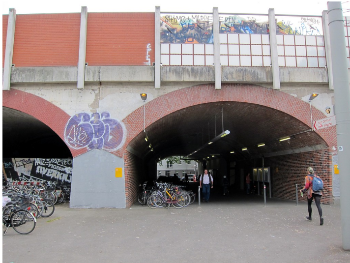
Östlicher Zugang zum Bahnhof Köln-Ehrenfeld an der Ecke Ehrenfeldgürtel/Hüttenstraße (2015). Für den Zugang wurde eines der Gewölbe der Viaduktbrücke, auf der die Bahnstrecke hier verläuft, saniert und geöffnet. Fotograf/Urheber: Knieps, Elmar
